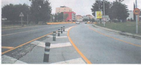
Acceso a la rotonda de la N-150, desde Cerdanyola
